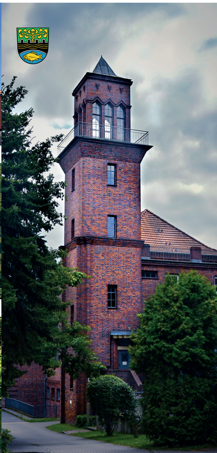
Elektrownia wodna | Wasserkraftwerk
