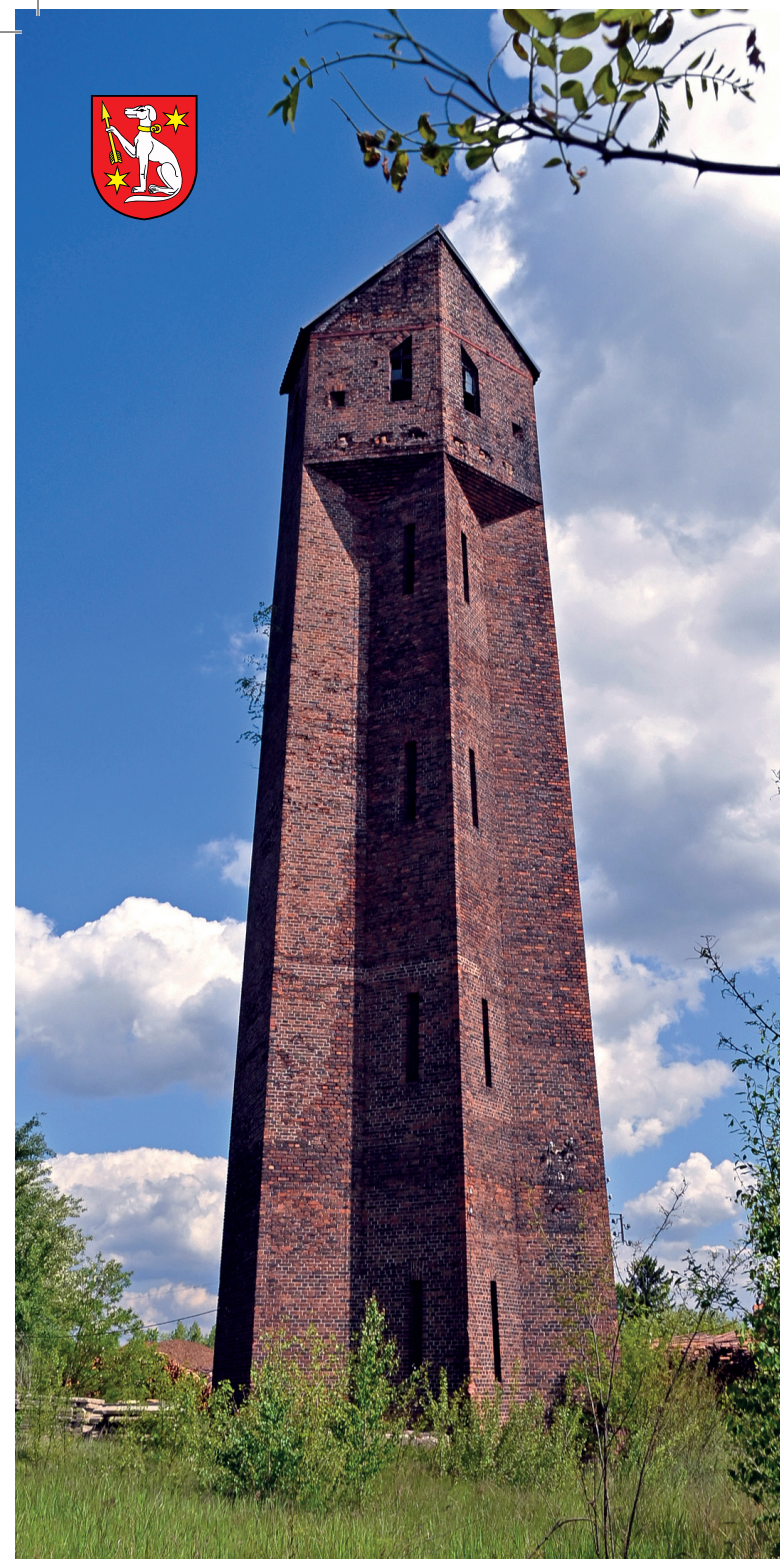
Wieża ciśnien w Jankowej Żagańskiej | Der Wasserturm in Jankowa Żagańska
